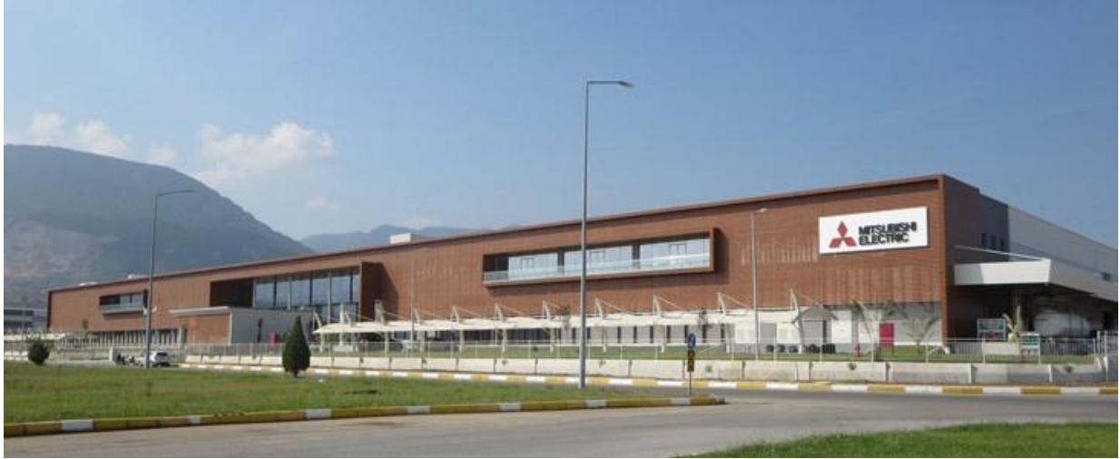
Mitsubishi Electric Turkey Klima Sistemleri Üretim A.Ş.
