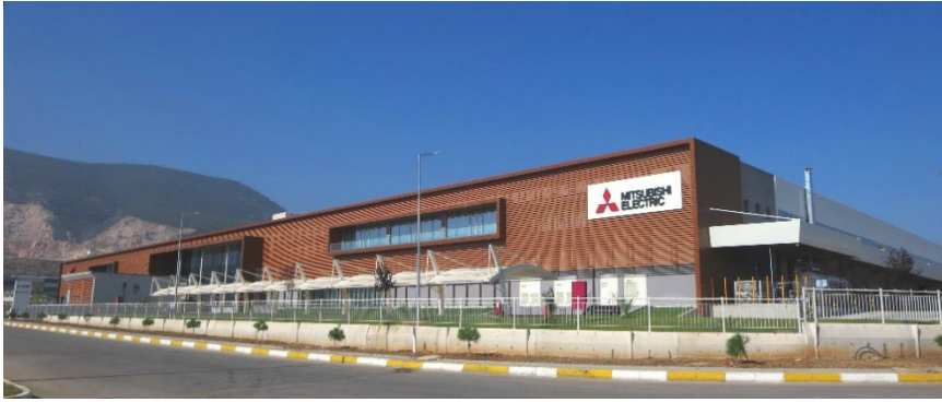
Mitsubishi Electric Turkey Klima Sistemleri Üretim A.Ş. (Fabrika 1)
